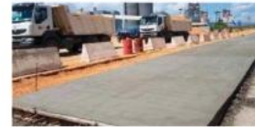
KONSTRUKSI JALAN TOL
